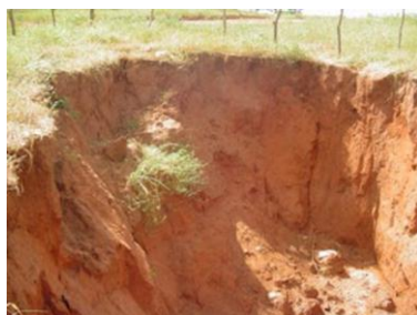
Problemas de erosão em solo arenoso.
